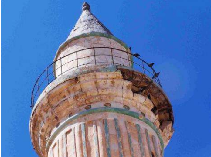
لوحة (٤) صورة تبين التصدعات التي أصابت مئذنة جامع رشيد باشا
