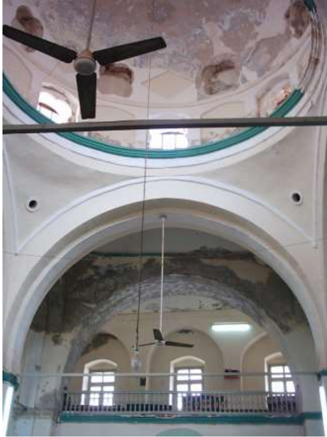
لوحة (٣) صورة تبين السدة ومنطقة الانتقال وجزء من قبة جامع رشيد باشا
